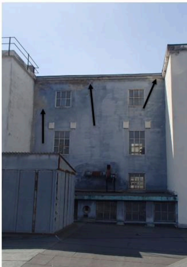
Figur 17: Midtre del av fasade øst. Omfattende puss og betongavskalling i øvre del av veggen og oppunder gesimsen. Malingsavflassing i søndre del av veggen
