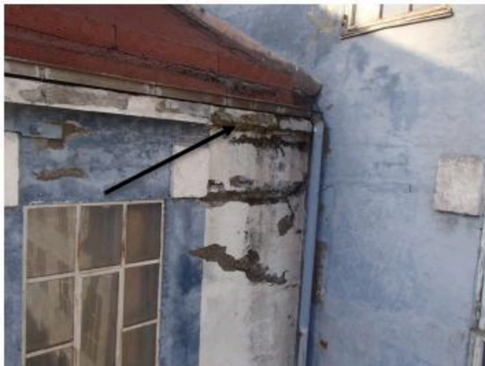
Figur 9: Fasade syd på vestfløy. Omfattende betongavskalling, sprekker og frilagt korrodert armering i gesims.
