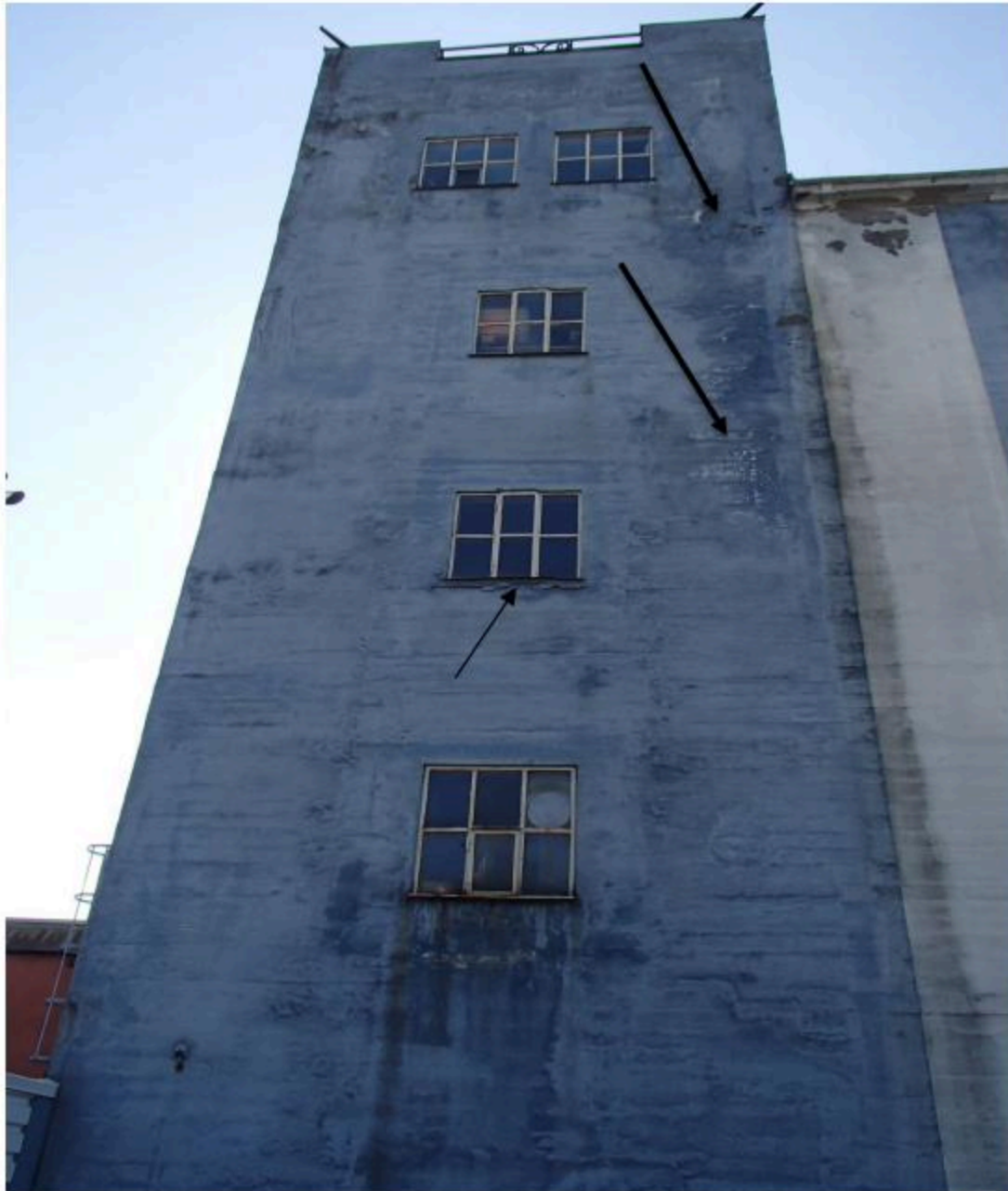
Figur 19: Fasade nord. Omfattende krakelering med salt- og kalkutslag på øvre halvdel av fasade. Punktavskallinger av betong og skade under vindu som følge av armeringskorrosjon.
