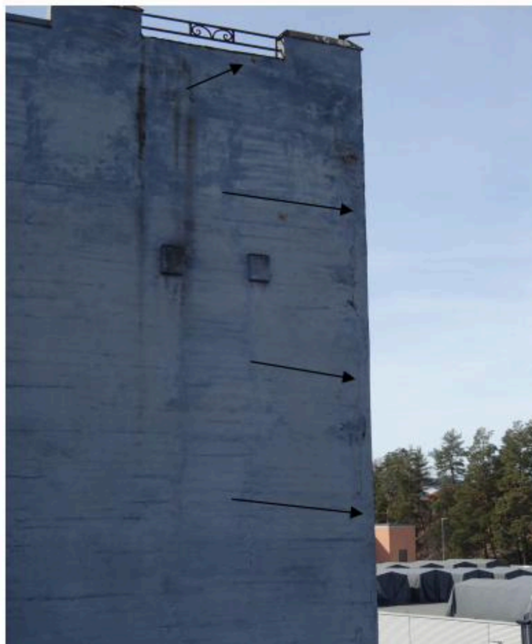
Figur 18: Nordre del av fasade øst. Vertikal sprekk langs hjørne nordøst. Riss i overgang mellom parapet og toppvegg.
