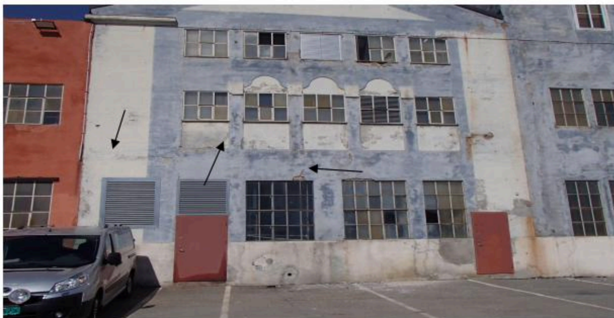
Figur 8: Mange felt med betongavskallinger og frilagt korrodert armering rundt vindusutsparinger og flere kraftige riss → i fasadene.
