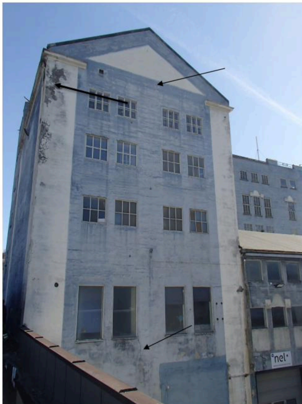
Figur 13: Gavlfasade vest. Større felter med betong og pusskader i hjørne nordvest. For øvrig en del riss med varierende lengde og vidde.
