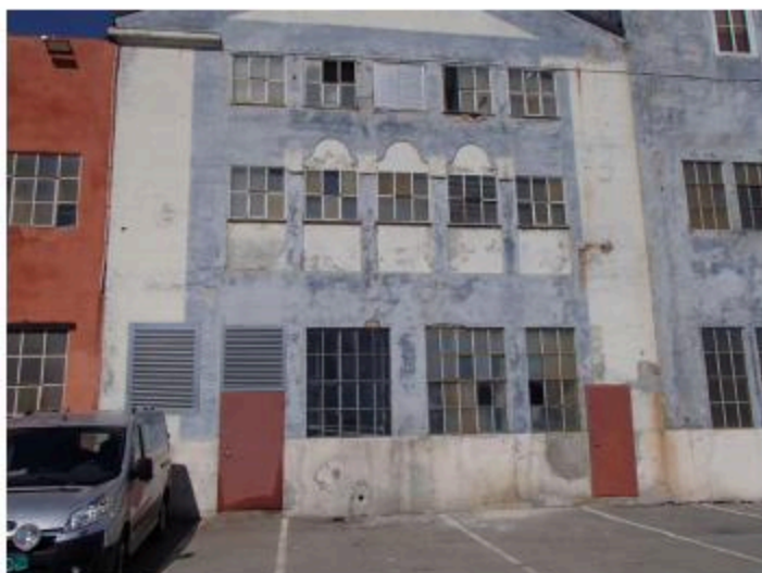
Figur 6: Gavlfasade syd på bygg fra 1918 med felter med malingsavflassing av både hvit og blå maling og misfarging etter avrenning
