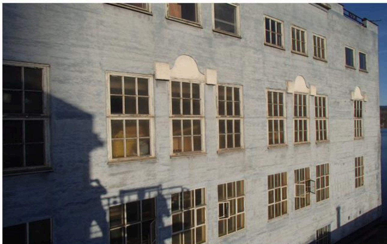
Figur 14: Langfasade mot vest. Relativt lite skader i form av malingsavflassing, betongavskalling og frilagt korrodert armering.
