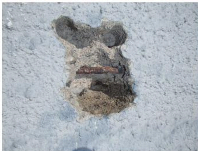
Figur 21: Typisk armering med rustgrad C.
