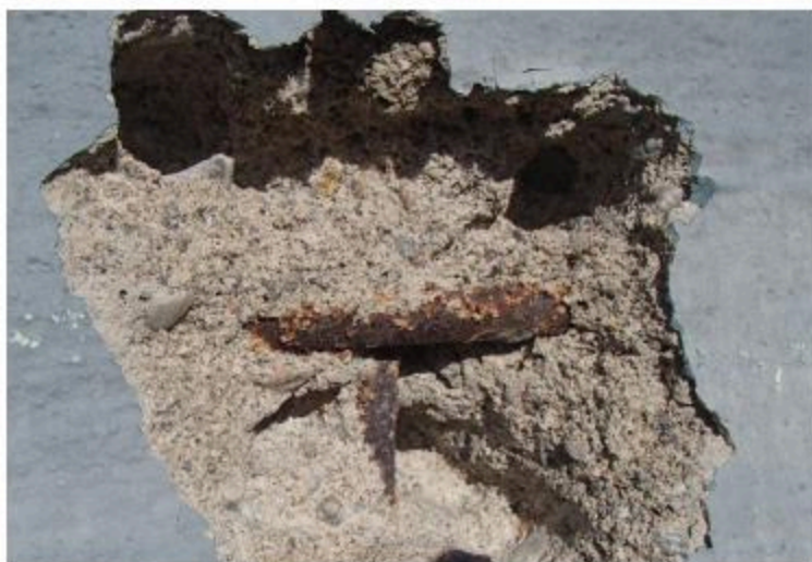
Figur 23: Porøs betong med svært lite bindemiddel og lav fasthet.
