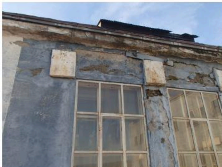
Figur 10: Langfasade syd på vestfløy. Omfattende betongskader i både gesims og deler av veggflatene.
