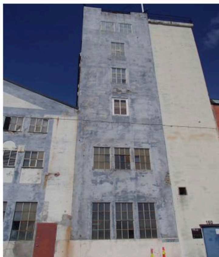
Figur 15. Fasade syd. Flere felt med betongavskallinger og frilagt korrodert armering.
